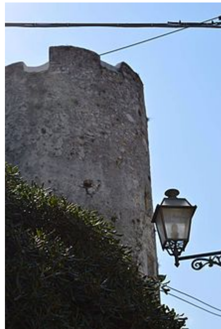
Torre della cinta muraria di Vico del Gargano
