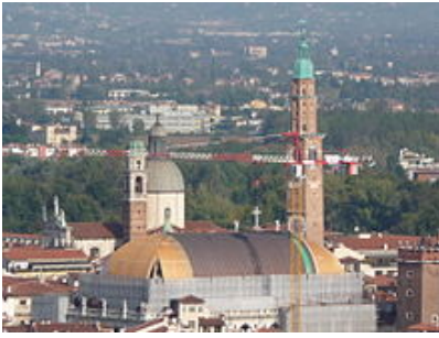
I lavori di restauro alla Basilica Palladiana
