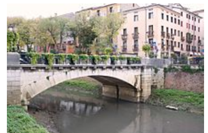
Ponte San Paolo
