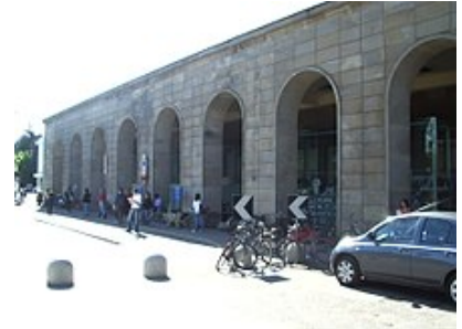
Ala centrale della stazione di Vicenza
