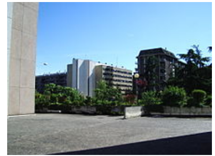
Zona residenziale di via btg. Framarin
