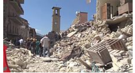
Effetti del Terremoto del 2016
